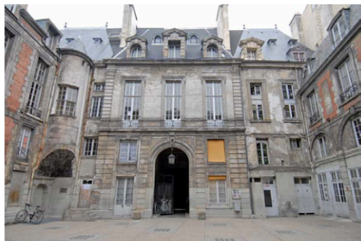
Ci-dessus : façades sur cour actuelle ; revers de l'extension de Coulomb.
